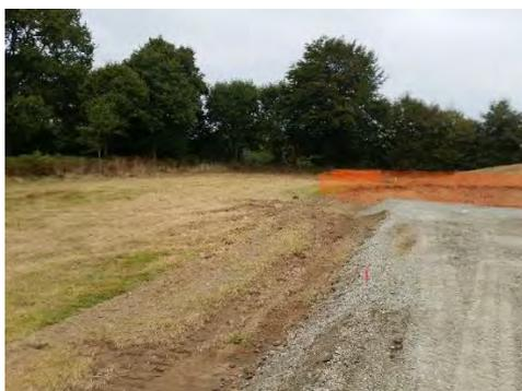
Photo 54 – Exemple de filet de chantier permettant de délimiter des emprises au sol.
