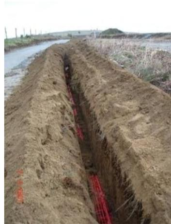
Photo 51 – Tranchée et câble inséré simultanément
